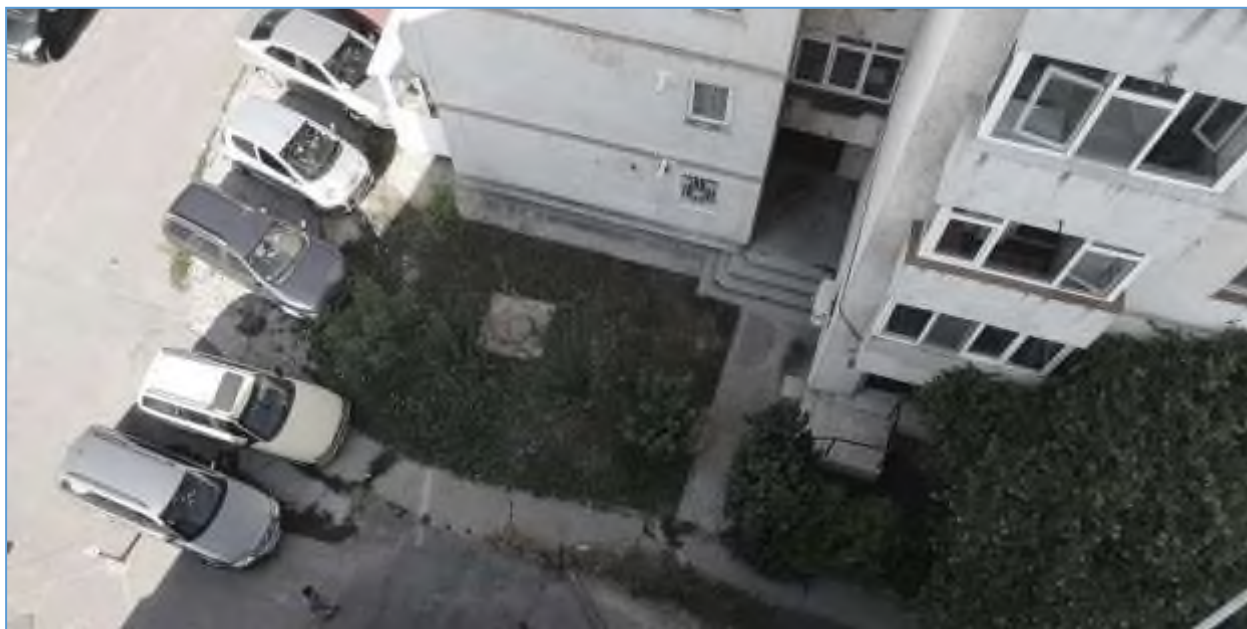
Figure 6-Reprezentare situație existentă a ansamblului de locuințe colective existente în care autoturismele sunt parcate pe circulația pietonală chiar și spațiu verde parțial..
