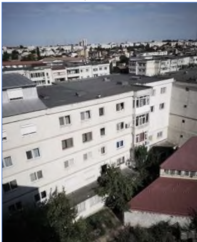
Figure 3-Reprezentare situație existentă a ansamblului de locuințe colective existente față posterioară.
